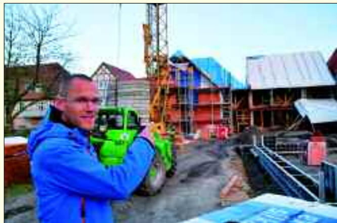
Bürgermeister Frederik Bewer auf der Baustelle auf der Rückseite des „Hauses Uckermark“. Rechts das Fundament für den Erweiterungsbau, in dem die Bibliothek und ein Depot unterkommen sollen.
