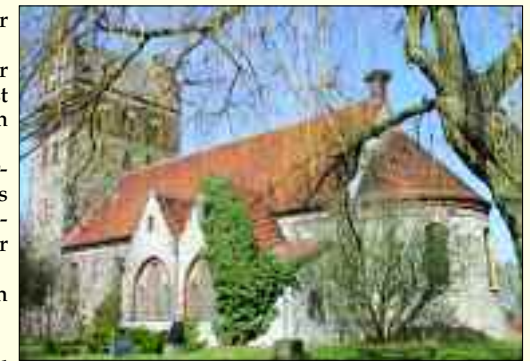
Die Deetz Feldsteinkirche aus dem Mittelalter dominiert das Ortsbild
