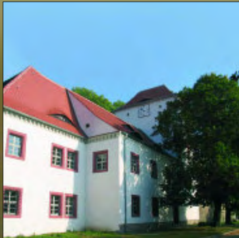
In liebevoller Handarbeit wurden schon diverse Sanierungsarbeiten an der Fassade durchgeführt
