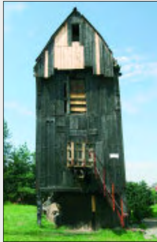
Die Mühle im heutigen Zustand
