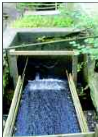
Die Mönchmühle ist über 770 Jahre alt und damit die älteste Wassermühle Brandenburgs.
