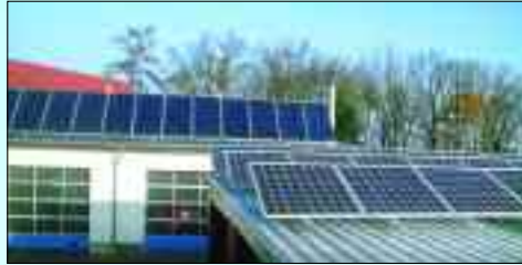
Beispiel einer Solar-Anlage für Heizungsunterstützung und Stromerzeugung
