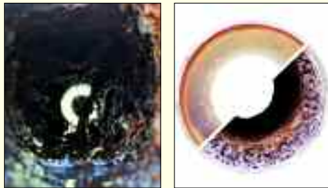
Bei TV-Inspektion gefundener Wurzeleinwuchs (li.) Vor und nach der Sanierung (re.)
