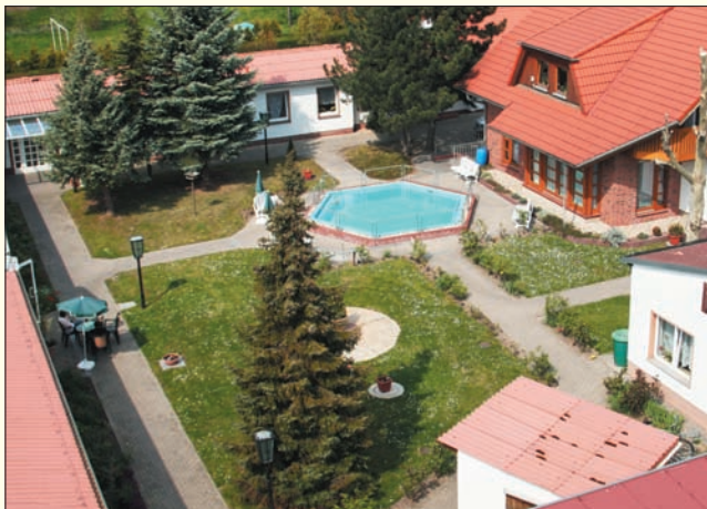
Hier in der modernen Kernwohnanlage des Hauses Auenblick in der Fabrikstraße lässt es sich gut leben.
